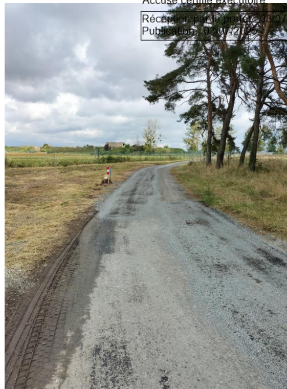
Réparation voirie nord – Sortie BA 705
