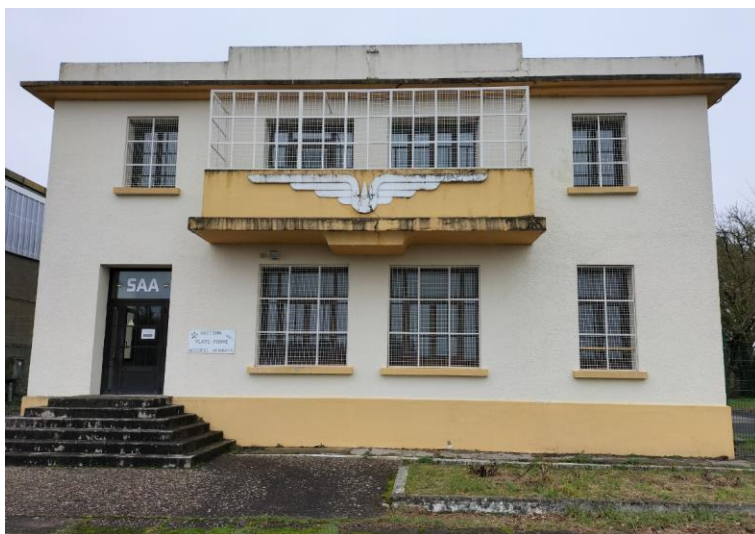
Sécurisation du bâtiment 001 suite audit DSAC
