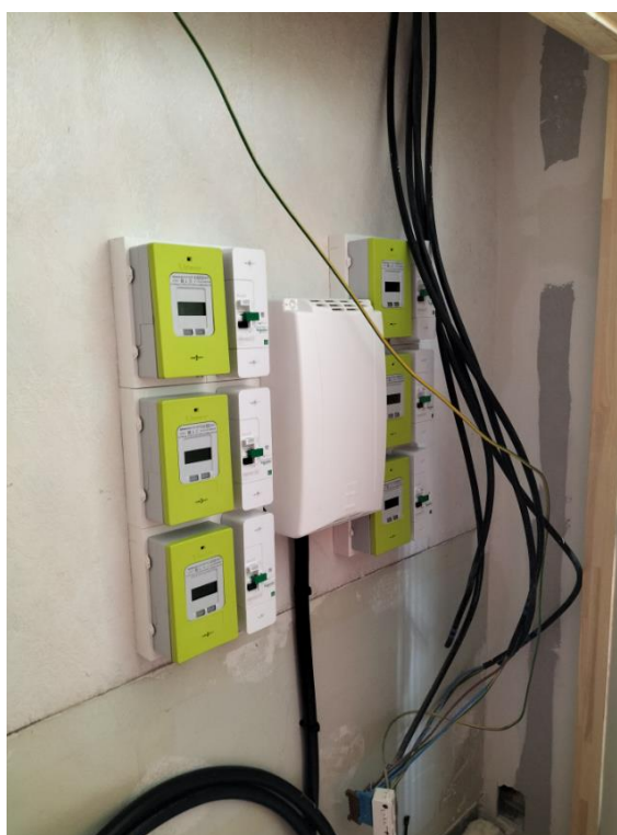
Viabilisation des bâtiments avec ENEDIS
