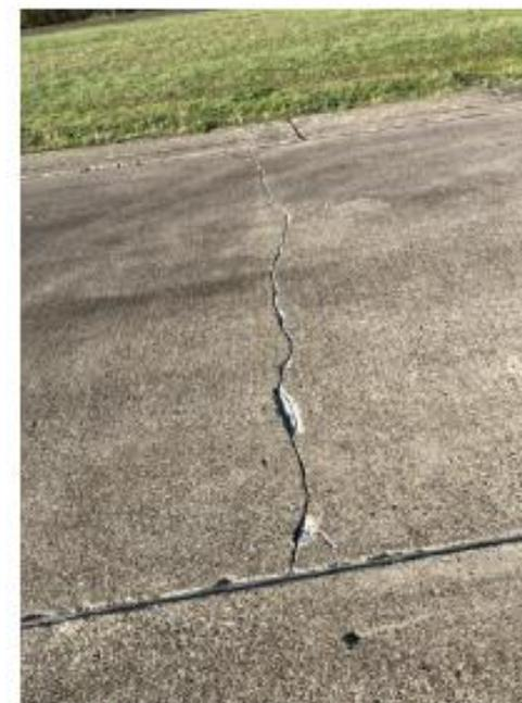
Figure 6: Fissure de gravité élevée
